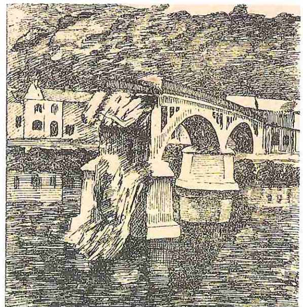
Vernielde brug over de Maas te Dinant.
